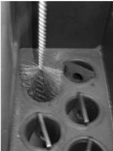
Les tubes de fumée sont le principal récupérateur d'énergie. Situés en fin de parcours des gaz de combustion, ils accumulent peu de cendres et suies. Néanmoins pour conserver un rendement optimal de la chaudière, il est nécessaire de les nettoyer régulièrement, chaudière à l'arrêt, dès qu'une couche de cendres d'environ 3 à 5 mm s'y est déposée. Il est possible de procéder à des nettoyages plus fréquents.
