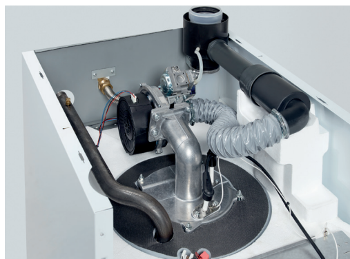
Accès à la chambre de combustion
